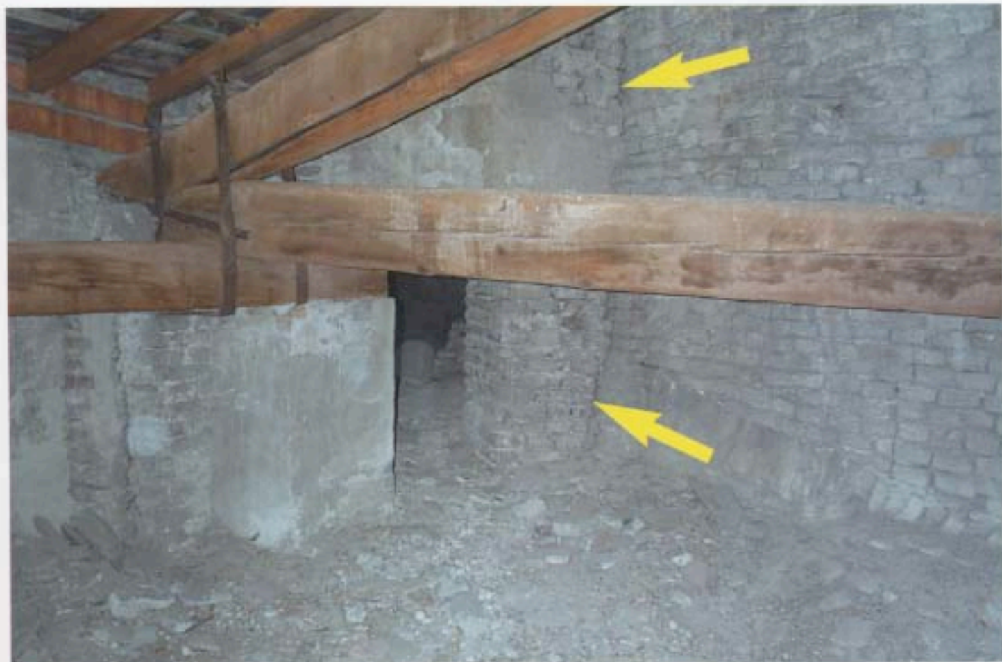
Figura 11. Discretizzazione dei puntoni estradossali.
