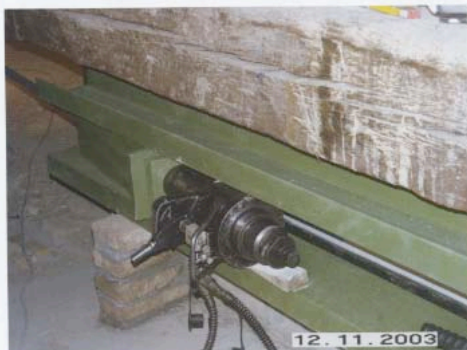
Figura 22. Sistema di pretensionamento delle catene con martinetto idraulico.
