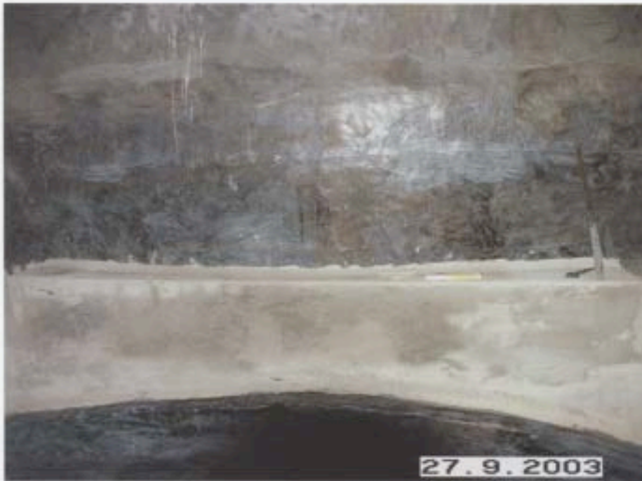
Figura 18. Fasciatura del tamburo con CFRP.
